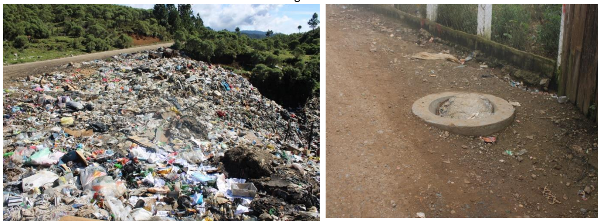
Figura 5 Basurero clandestino y drenaje colapsado, aldea Yichk'aw, San Mateo Ixtatan, Huehuetenango
